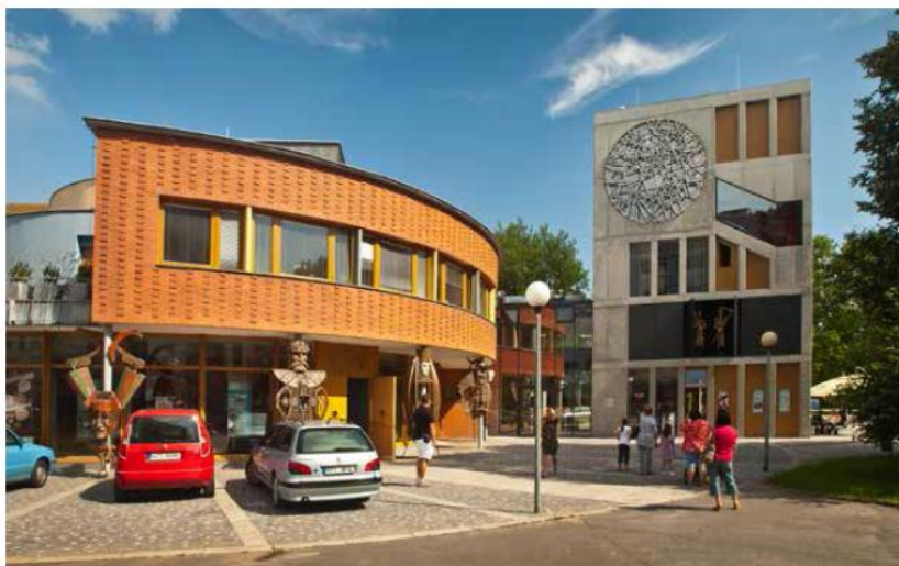
Přístavbu divadla loutek zdobí orloj tvořený hvězdnými hodinami a galerií pohyblivých loutek. První premiéra se na nové scéně konala v květnu 2011.
